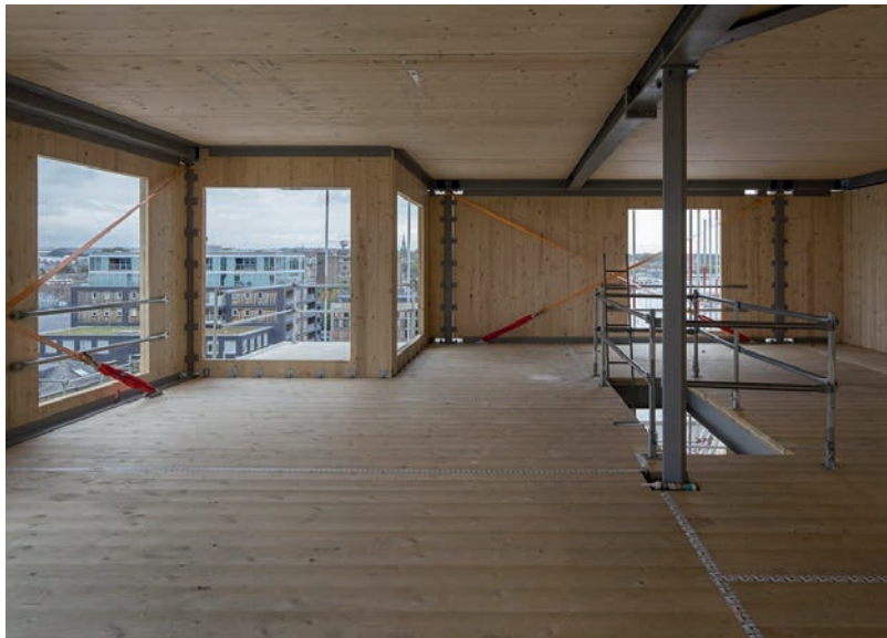
Acélszerkezetek a 10 emeletes Bayan Wharf-i irodaépületben (tervező – Hawkins & Brown)
