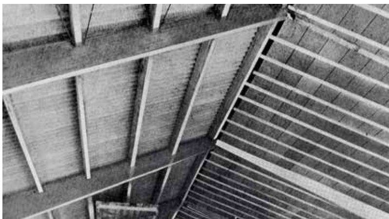
Hőszigetelés cementkötésű fagyapot lemezzel
