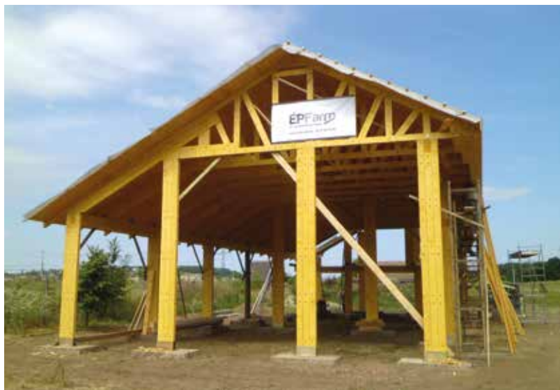
Mezőgazdasági épület teljes szerkezete keményfacsapokkal, gyorsan, gazdaságosan
