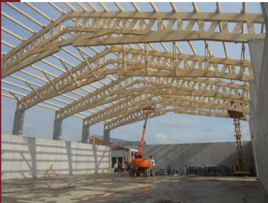
Nagy fesztávolságú csarnok tartószerkezete keményfacsapos megoldással
