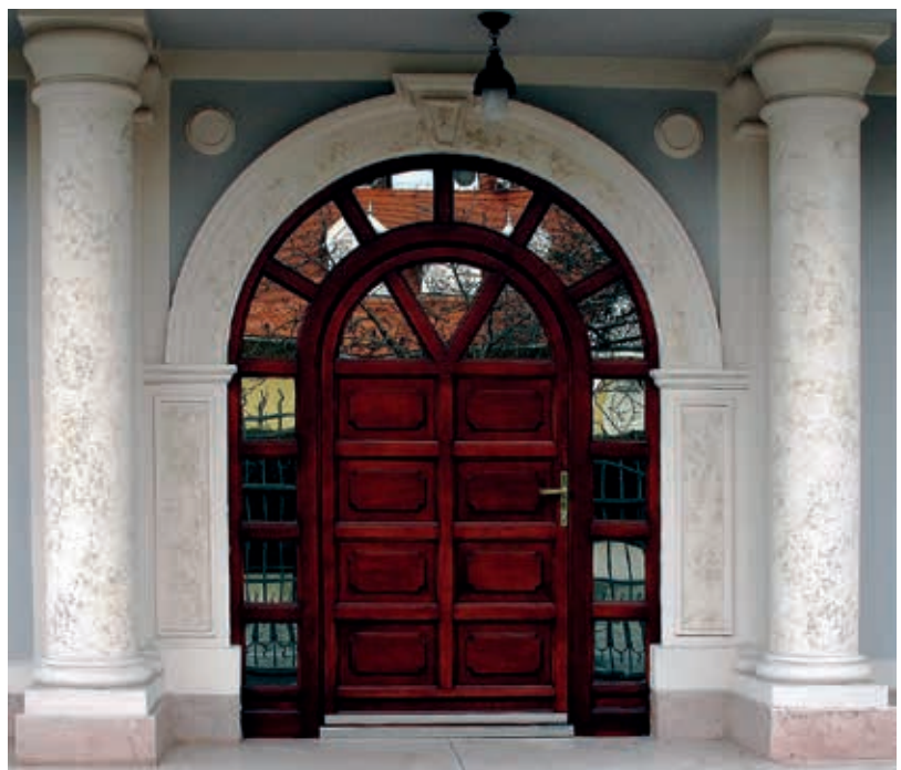
2. sz. kép: kapu vázszerkezete, legegyszerűbben kontraprofilos kötással készíthető
