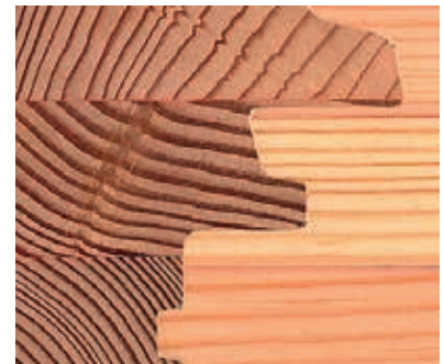
7. sz. kép: ablaktok csapos és kontraprofilos kötése
