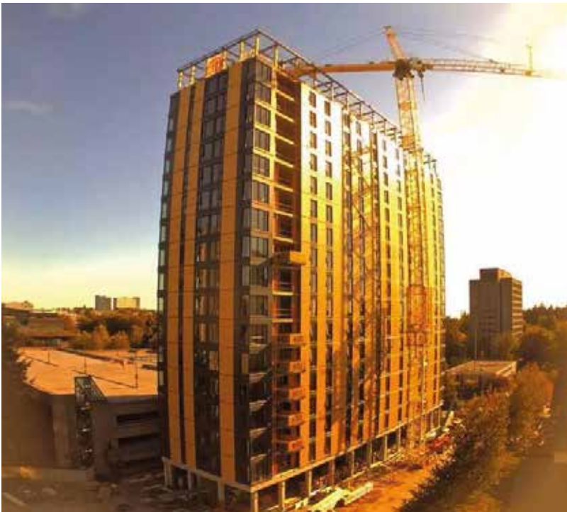
Canada Brock Commons 19 emeletes kollégiumépület ( www.worldarchitecturenews.com )
