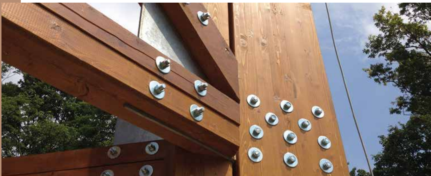
Kövestető kilátó rétegragasztott gerendái. Forrás: Szabó Péter
