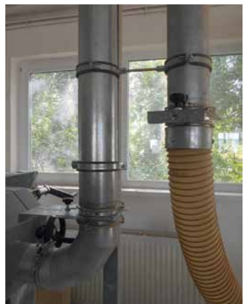
Csatlakoztatási lehetőségek: csőkönyökkel vagy flexibilis csövekkel (Benedek Tibor)
