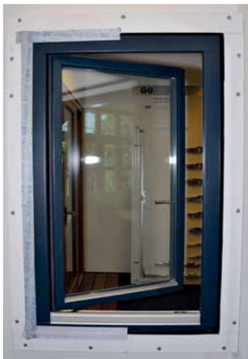
Ablak G-U Vorbauzarge rendszerrel beépítve, megtekinthető a vállalat budapesti bemutatótermében
