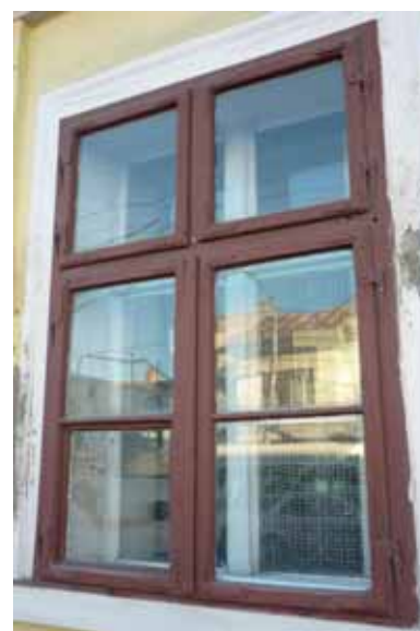
A 150–180 éves kapcsolt gerébtokos, ki-be nyíló ablak kézműves munkával még felújítható volna
