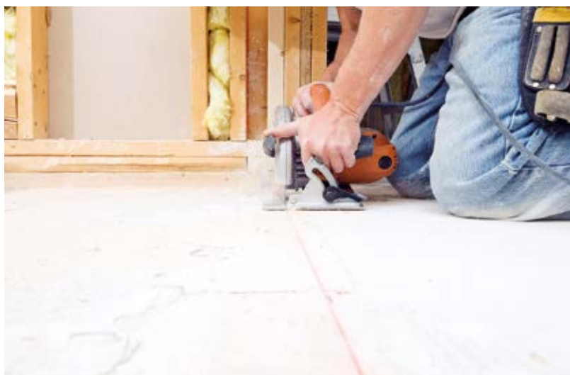
Szintezőlézer padlóra kivetítve
