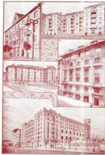
Részben ma is álló budapesti referenciáépületek
