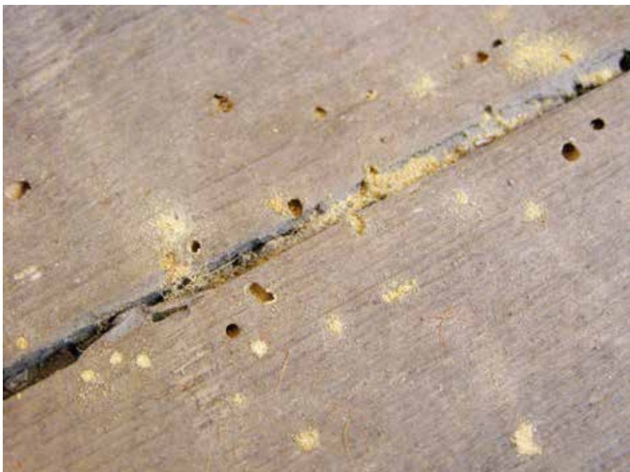
4. kép: Rovarrágás nyomai beépített faanyag esetén
