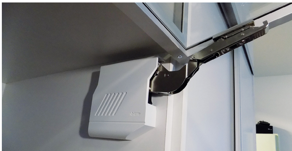
Keskeny alukeret Blum Aventos HK-S vasalatrendszerrel szerelve
