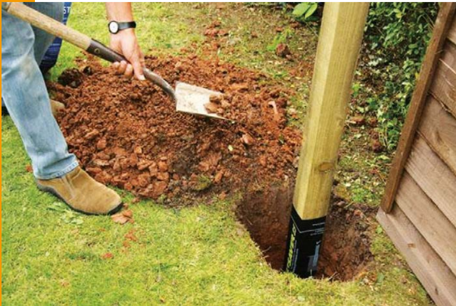
Postsaver fóliával védett oszlop telepítése
