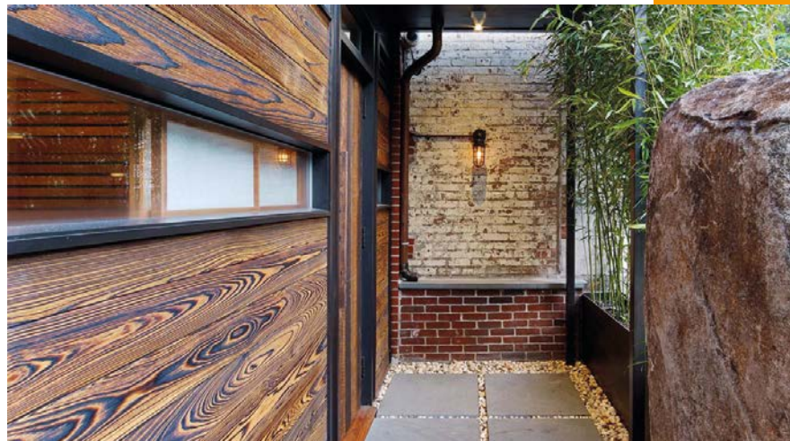
Égetéses felületkezelés homlokzati burkolaton
