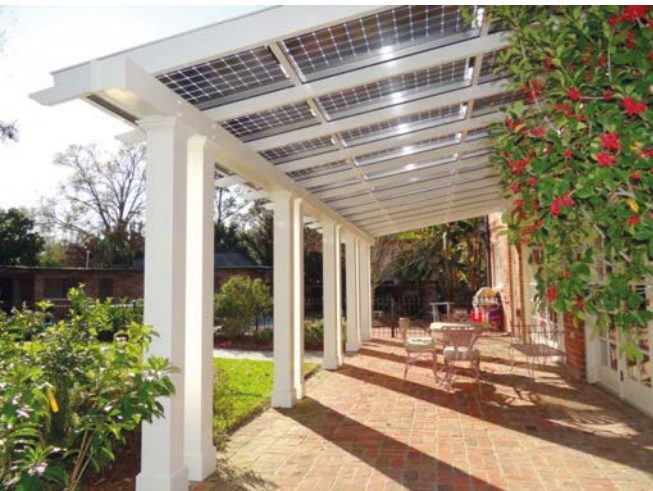
Tornáckialakítás oszlopos tetőszerkezettel, napelemmel
