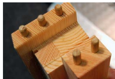
2. kép: illesztett kontraprofil köldökcsappal
