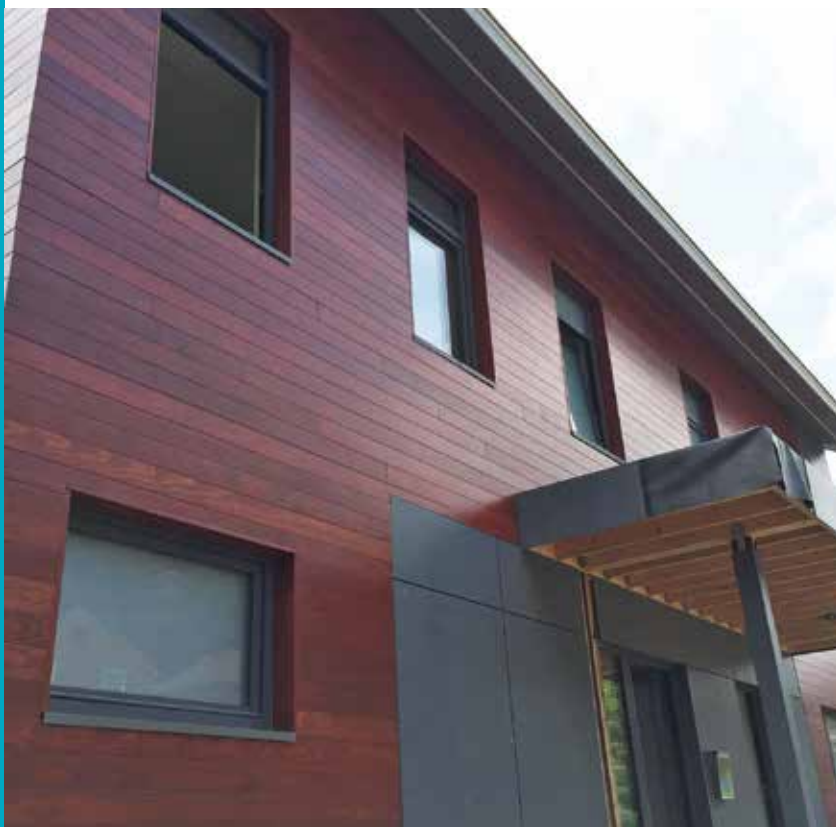
Faház hatást keltő homlokzati burkolat az acetilezett Accoya faanyaggal
