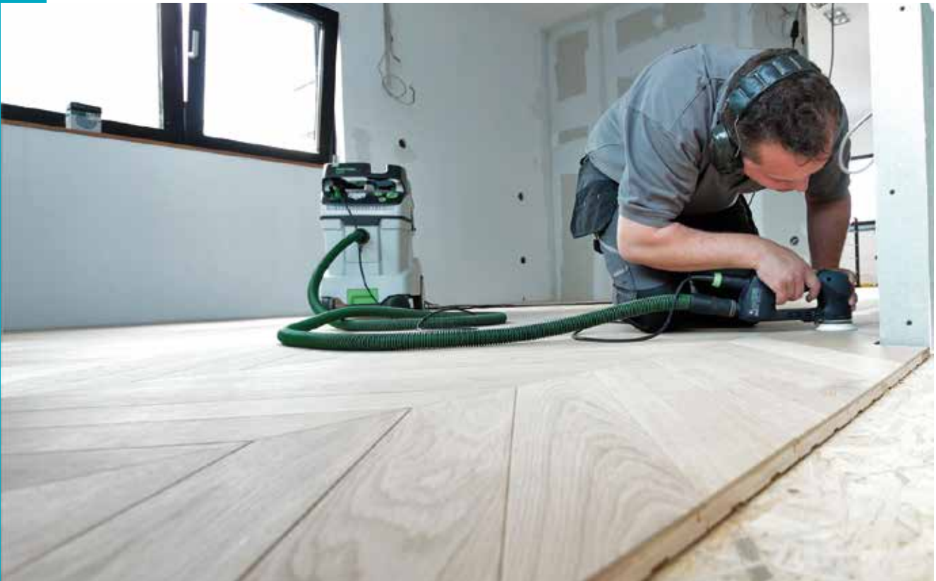
Áttételes hajtású excenteres csiszológép munka közben
