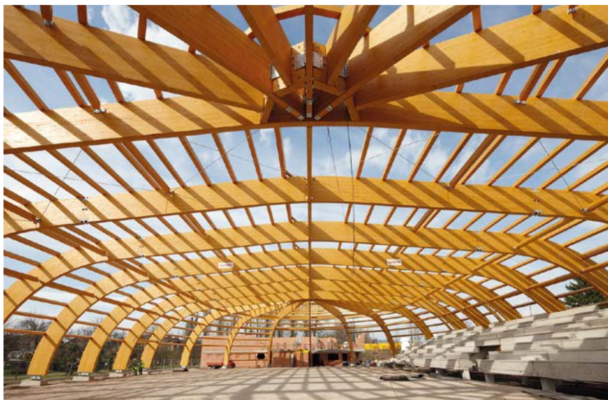
Jéghoki Aréna Jicin, Csehország. Különbséget kell tenni a tömbösített fa és a teherhordásra alkalmas RR tartók között Forrás: KASPER CZ s.r.o.
